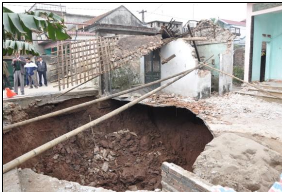
Рис. 3. Обвал земной поверхности в районе Мидык в декабре 2010 г.
