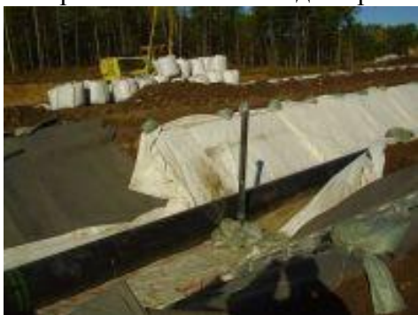
Рис. 1. Водонепроницаемые траншеи
